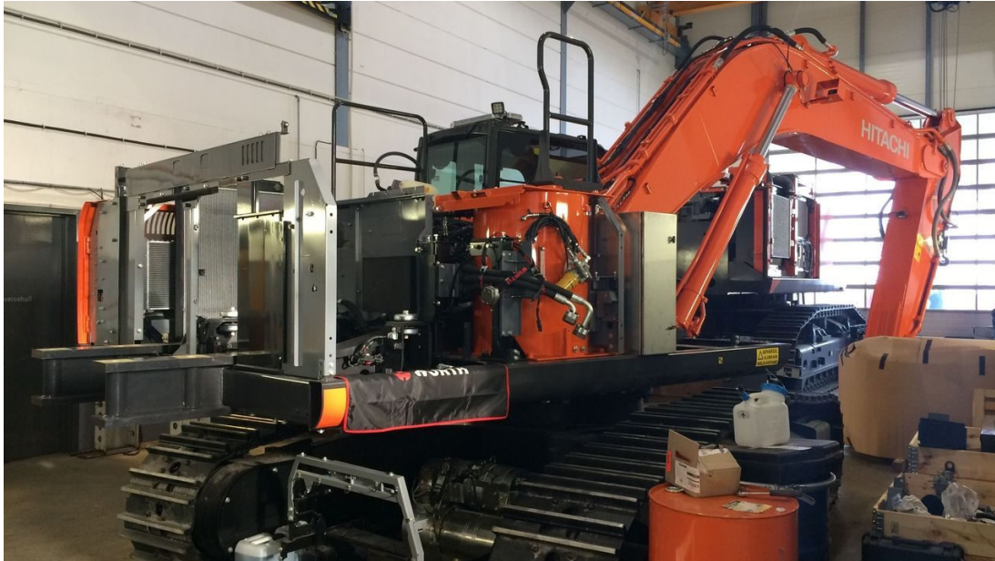
Figur 5. Fjerning av dieseltank og klargjøring av motor for ombygging. Kilde: NASTA.
