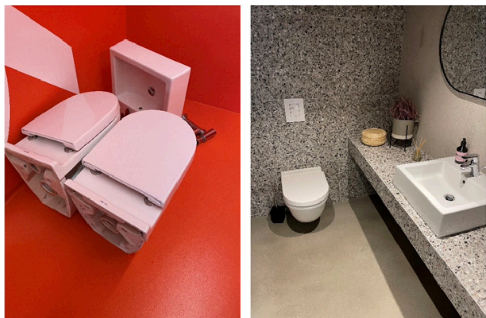
Mynd 6 Til vinstri: Handlaug og salerni hafa verið tekin niður á Kleppsvegi 152. Til hægri: Handlaug og salerni endurnýtt á nýrri starfstöð Arkís í Kópavogi.
