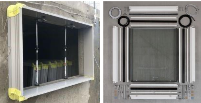
Mynd 5.13 Myndin sýnir glugga sem eru festir utan á bygginguna, ólíkt ísteyptum gluggum eins og tíðkast að nota á Íslandi. Mynd tekin frá danska gluggaframleiðandanum Outercore.
