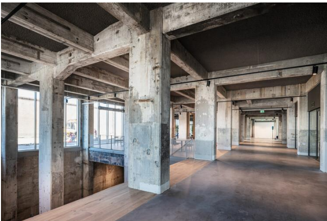
Mynd 5.4 Varðveisla steyptra burðarvirkja, eins og þess sem er sýnt á myndinni, býður upp á möguleikann að endurgera bygginguna að innan.
