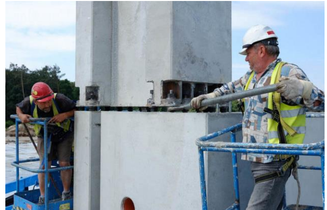
Mynd 5.5 Peikko er finnskt fyrirtæki sem framleiðir ýmis konar forsteyptar einingar. Peikko hefur þróað lausnir í átt að hringrásarhagkerfinu, m.a. forsteyptar súlur (sjá mynd) sem eru festar með mekanískum festingum.
