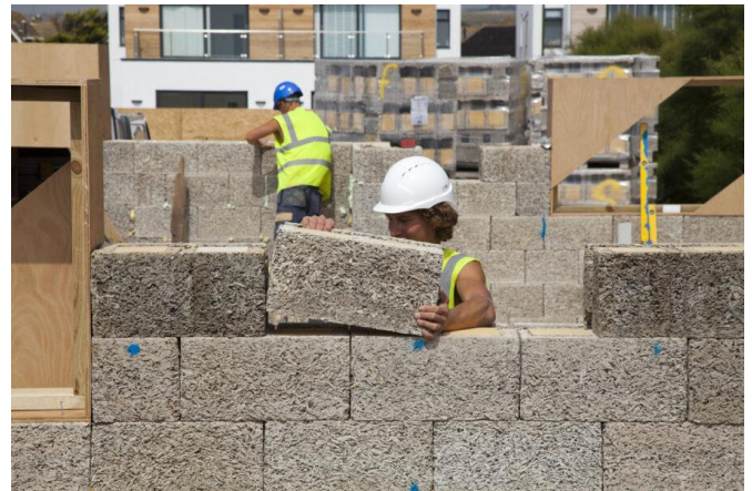
Mynd 5.2 Durisol byggingarkubbar eru dæmi um endurunnið byggingarefni. Kubbarnar eru búnir til úr endurunnum við sem er síðan steingerður.
